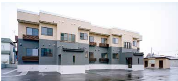
名寄法務総合庁舎職員宿舎 木造2階建て
