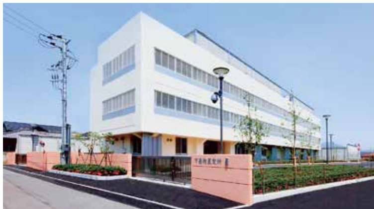
下妻拘置支所(1964年築)の改修(2018年)
